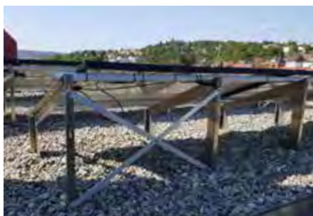
Vorgelochte Aluminium-Flachprofile, zur kreuzweisen Aussteifung zweier Solar-Grundrahmen.
