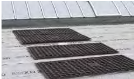
2. Anschließend werden die Solarbasisplatten ausgelegt.
