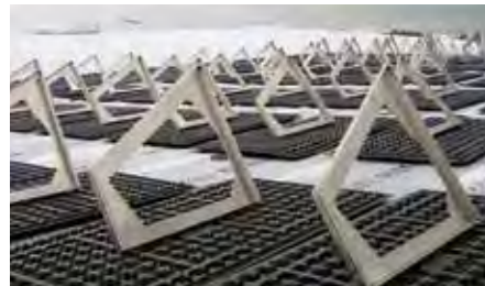
3. Auf den Solarbasisplatten werden die Solar-Grundrahmen platziert, ausgerichtet und mit nur zwei Muttern befestigt..
