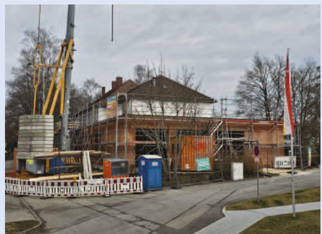
So sieht die Baustelle von der Markolfhalle aus. Bilder: Stadtverwaltung
