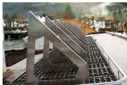
Rahmen 45° für Solar-Thermie auf 5° geneigter Dachfläche.
