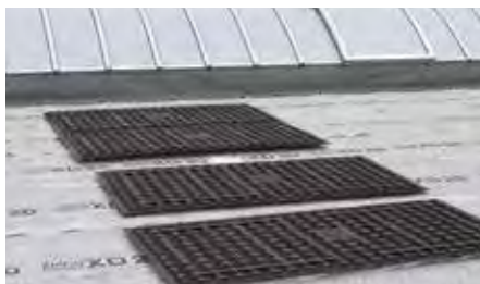
2. Anschließend werden die Solarbasisplatten ausgelegt.
