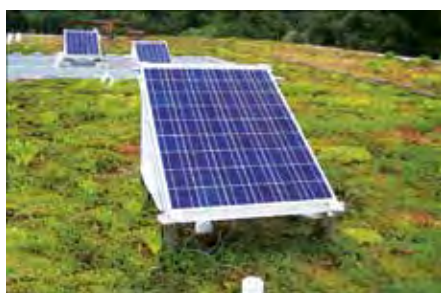
Hierbei wurden zwei Module über „nackten“ Bitumenbahnen und ein Modul über einer Dachbegrünung gegenübergestellt. Hauptaugenmerk galt den jeweiligen Temperaturen an den Unterseiten der Module.
