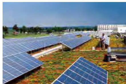
6. Das fertig begrünte Dach mit Solaranlage.
