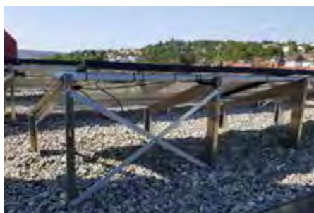
Vorgelochte Aluminium-Flachprofile, zur kreuzweisen Aussteifung zweier Solar-Grundrahmen.
