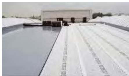
1. Die Dachabdichtung wird mit der hochwertigen Drän- und Schutzlage Fixodrain® XD 20 abgedeckt.
