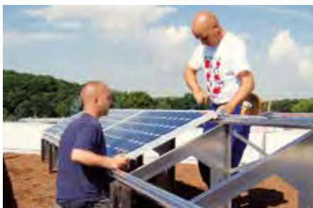
5. Die Solarmodule werden montiert.
