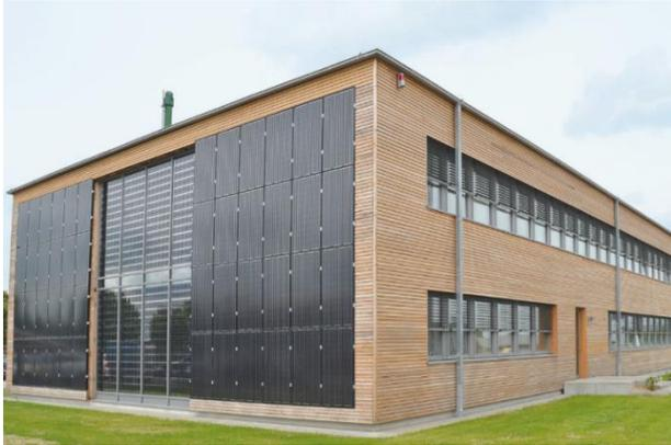
Abbildung 3: Fassaden-PV (Quelle: <https://www.solarcarporte.de/solarfassade/>)
