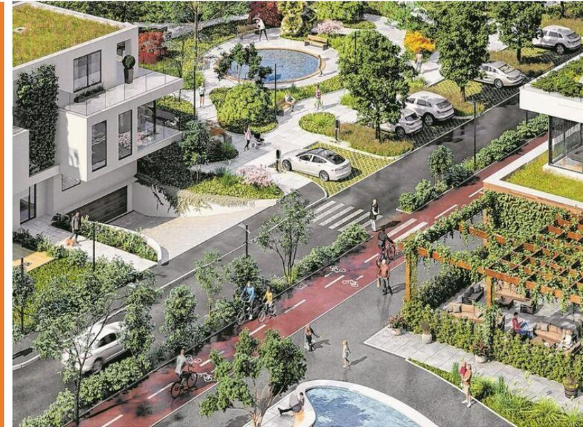
Prinzipien der Schwammstadt: **Zusammenwirken von Regenwasserrückhalt, -versickerung, Verdunstung und Kühlung** durch Elemente wie wasserdurchlässige Beläge, Versickerungsmulden, Verdunstung, Feuchtbiotop, Zisternen, Rigolen, Notabflusswege, Starkregennrückhalt, Gebäudebegrünung
