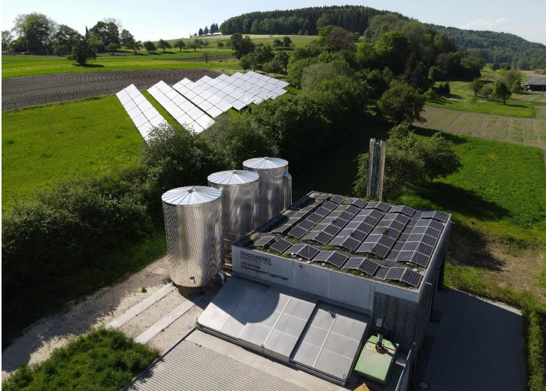
Abbildung 4-4 Solarenergiedorf Stadtwerke Radolfzell ( stadtwerke-radolfzell.de ) Wärmepumpen
