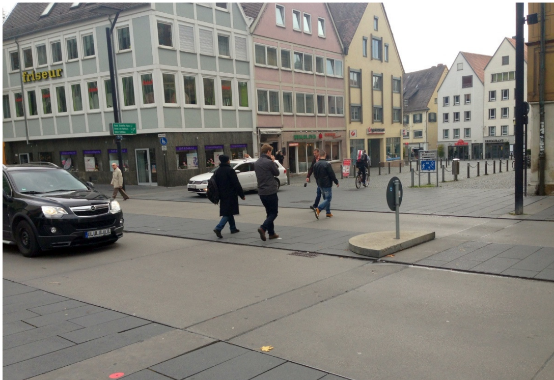
Abbildung 2: Überfahrbare Mittelinsel an einer Querungsstelle in Ulm (Neue Straße/ Marktplatz, Foto: R+T)
