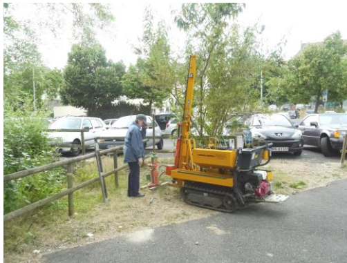
Abb.10: Rammkernsondierung am Ansatzpunkt RKS 8/14
