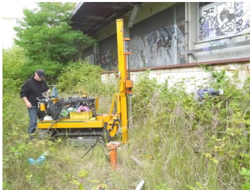
Abb.18: Schwere Rammsondierung am Ansatzpunkt DPH 2/14
