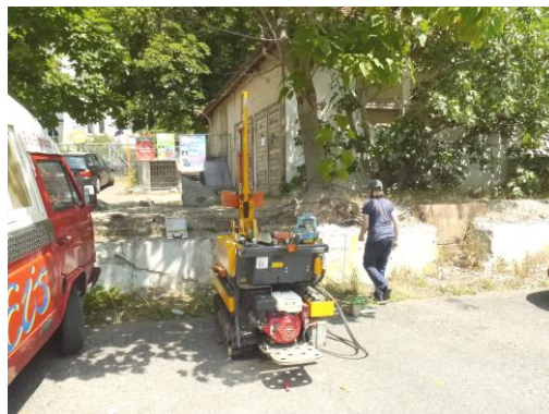
Abb.16: Rammkernsondierung am Ansatzpunkt RKS 14/14
