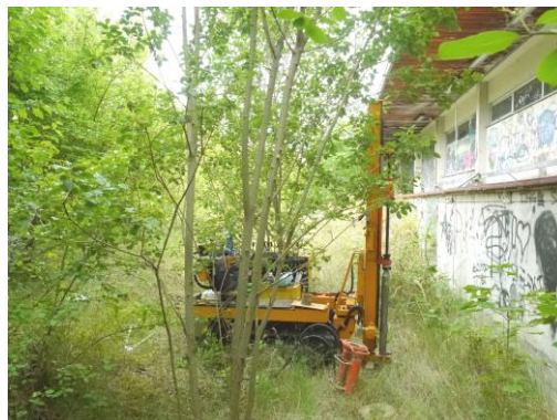
Abb.8: Rammkernsondierung am Ansatzpunkt RKS 6/14
