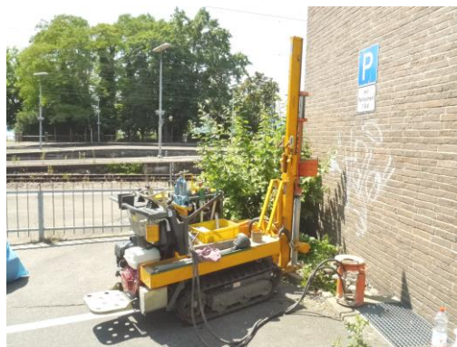
Abb.4: Rammkernsondierung am Ansatzpunkt RKS 2/14
