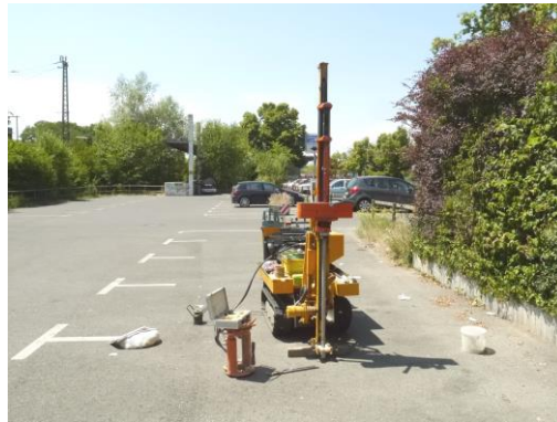
Abb.21: Schwere Rammsondierung am Ansatzpunkt DPH 5/14
