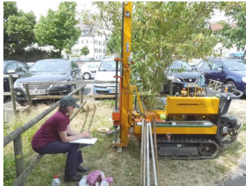
Abb.19: Schwere Rammsondierung am Ansatzpunkt DPH 3/14
