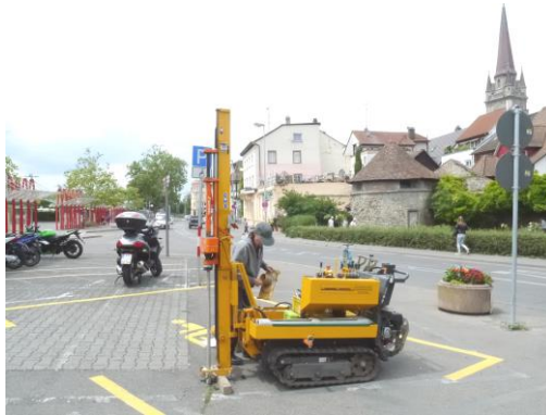
Abb.17: Schwere Rammsondierung am Ansatzpunkt DPH 1/14
