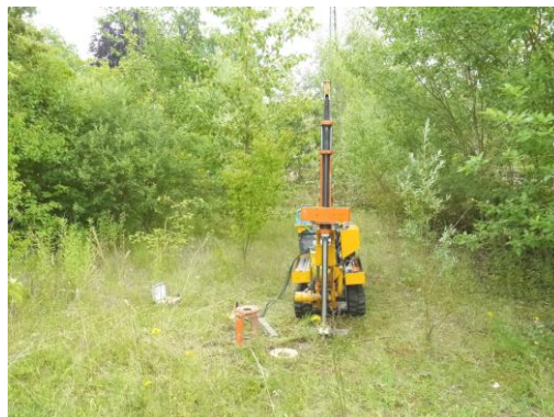
Abb.22: Schwere Rammsondierung am Ansatzpunkt DPH 6/14
