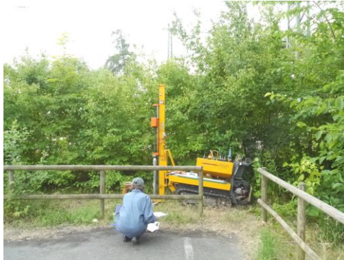
Abb.9: Rammkernsondierung am Ansatzpunkt RKS 7/14
