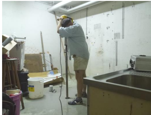
Abb.7: Rammkernsondierung am Ansatzpunkt RKS 5/14
