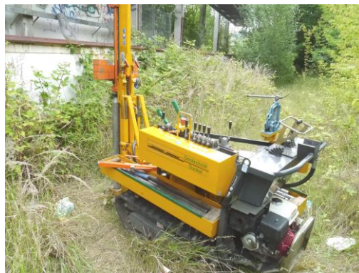
Abb.6: Rammkernsondierung am Ansatzpunkt RKS 4/14
