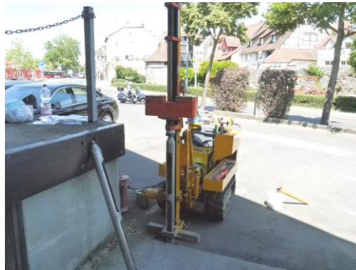
Abb.5: Rammkernsondierung am Ansatzpunkt RKS 3/14
