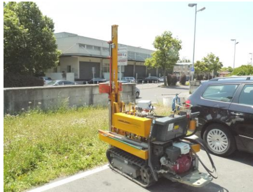
Abb.15: Rammkernsondierung am Ansatzpunkt RKS 13/14
