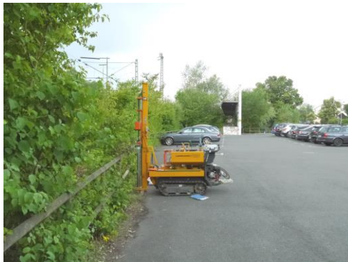
Abb.12: Rammkernsondierung am Ansatzpunkt RKS 10/14
