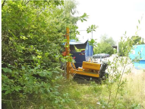
Abb.13: Rammkernsondierung am Ansatzpunkt RKS 11/14
